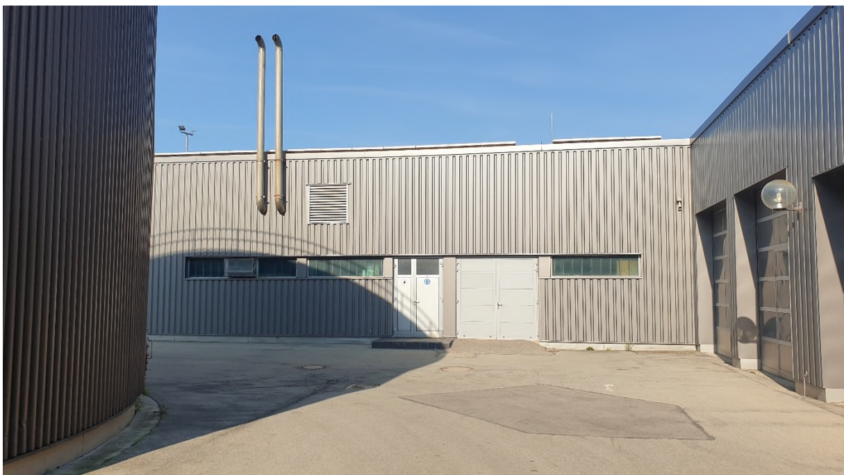
Abbildung 2: Betriebsgebäude mit Tor und Abgasanlage (Kamin)
