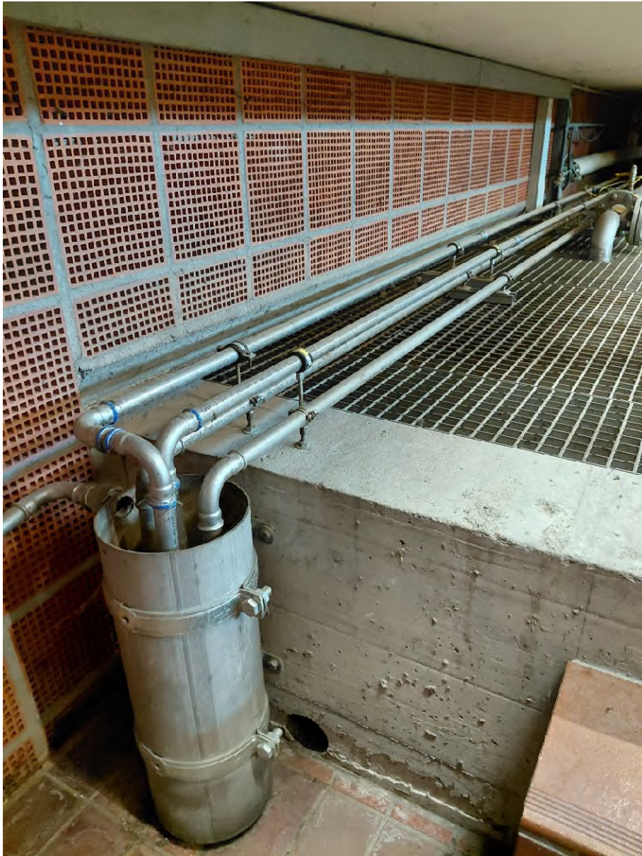
Abbildung 5: Kondensatopf
