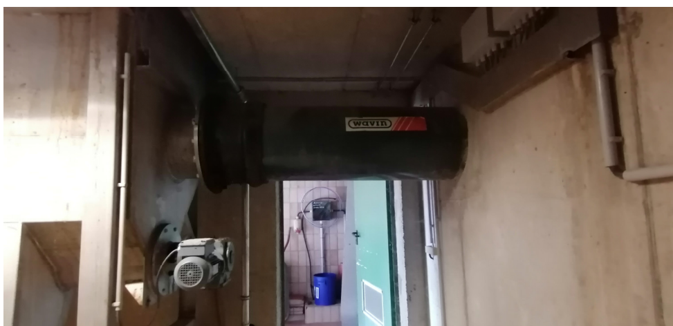
EG Rechengebäude: Zulauf Kompaktanlage Straße 1
