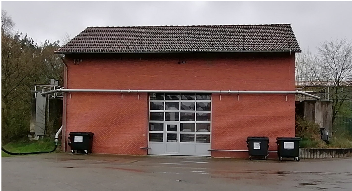
Rechengebäude: Vorderseite mit Tor
