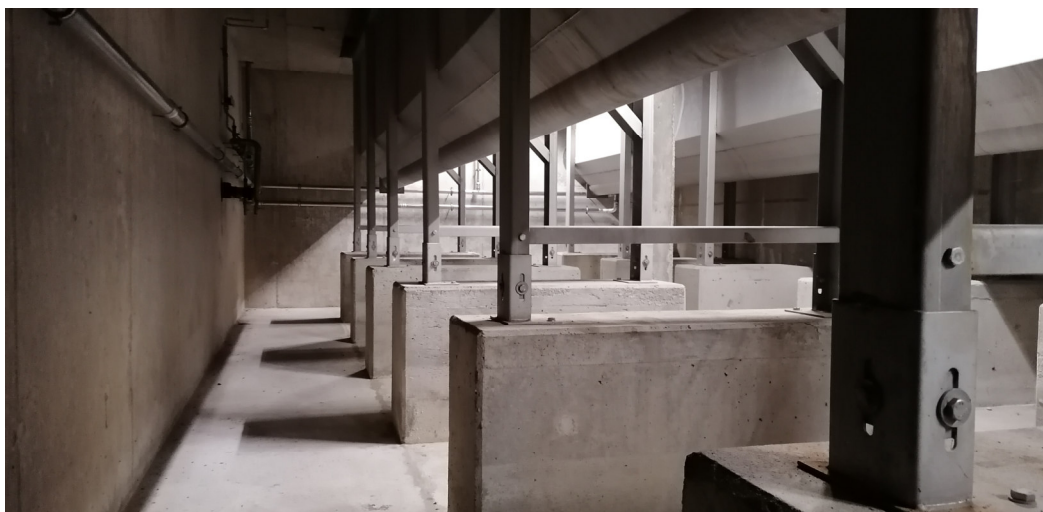
EG Rechengebäude: Sandfang
