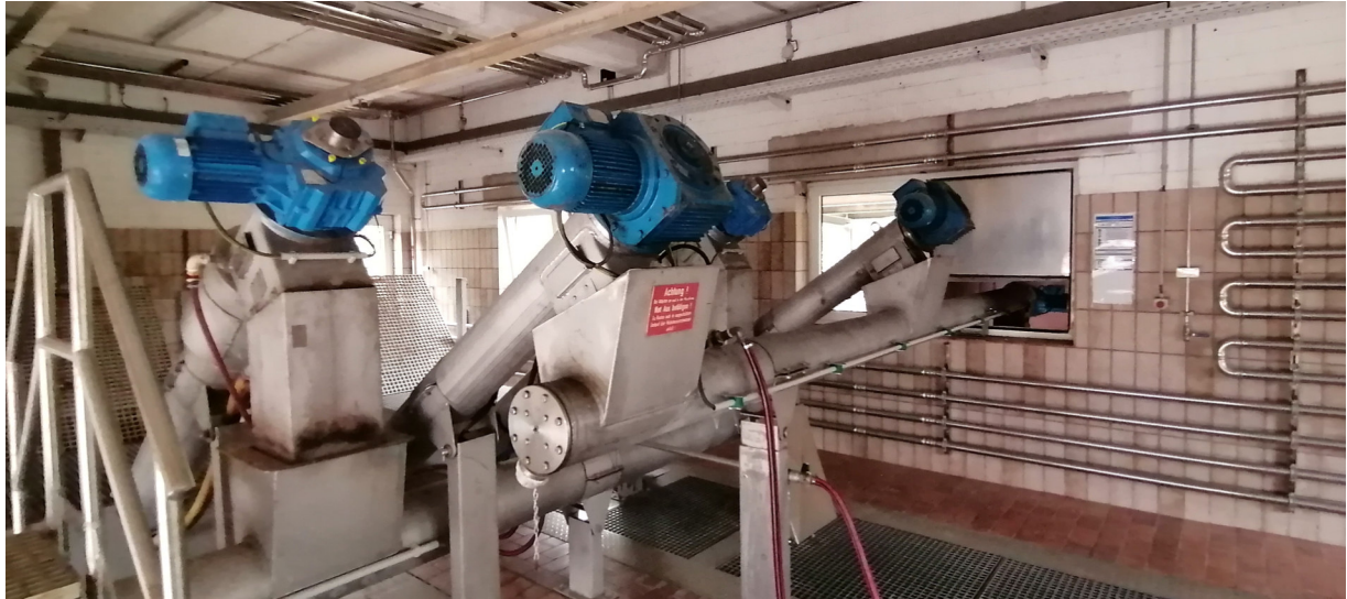
Rechengebäude: Austragsschnecken
