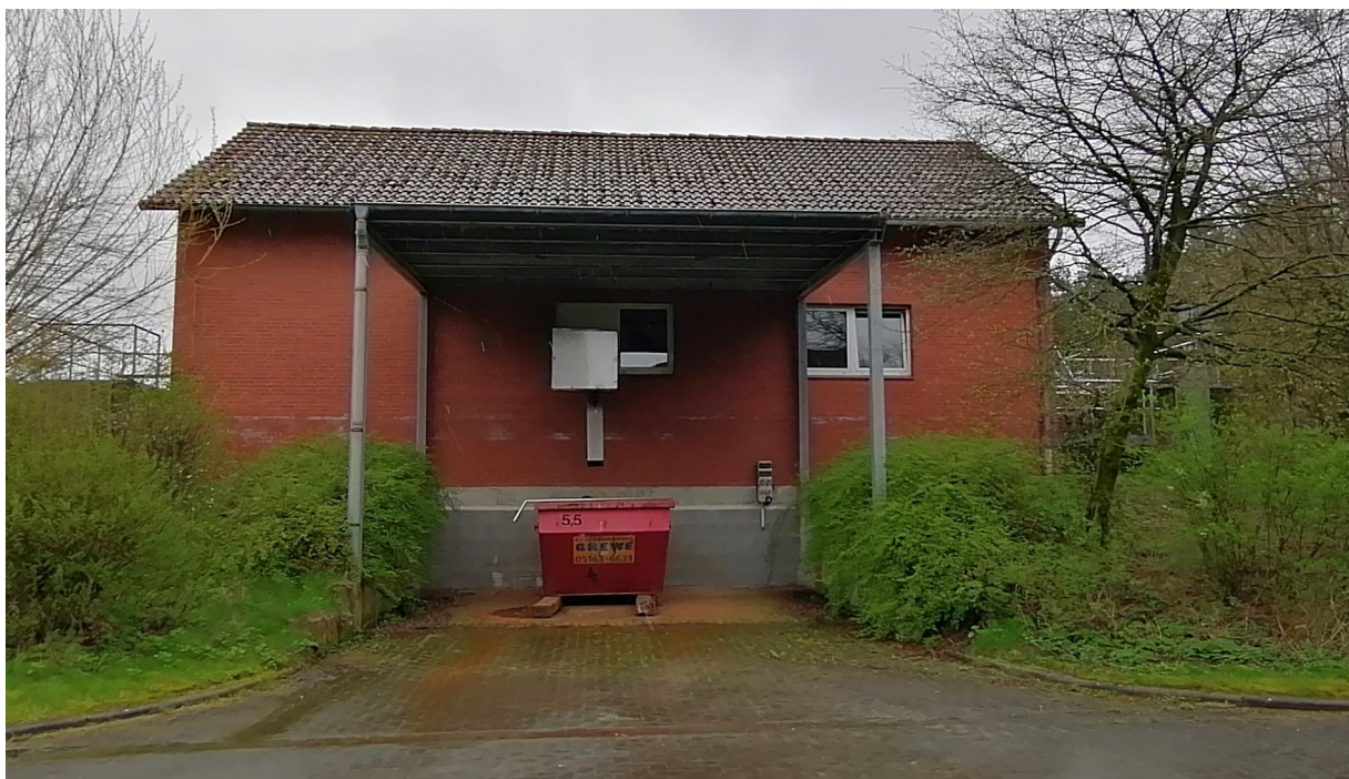
Rechengebäude: Rückseite mit Containerstellfläche
