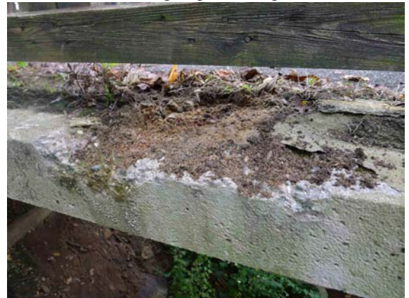
BETONABPLATZUNG PLATTE 05
