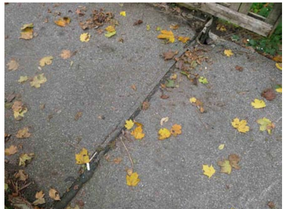
FUGE ÜBERBAU - UNTERBAU OFFEN UND BEWACHSEN
