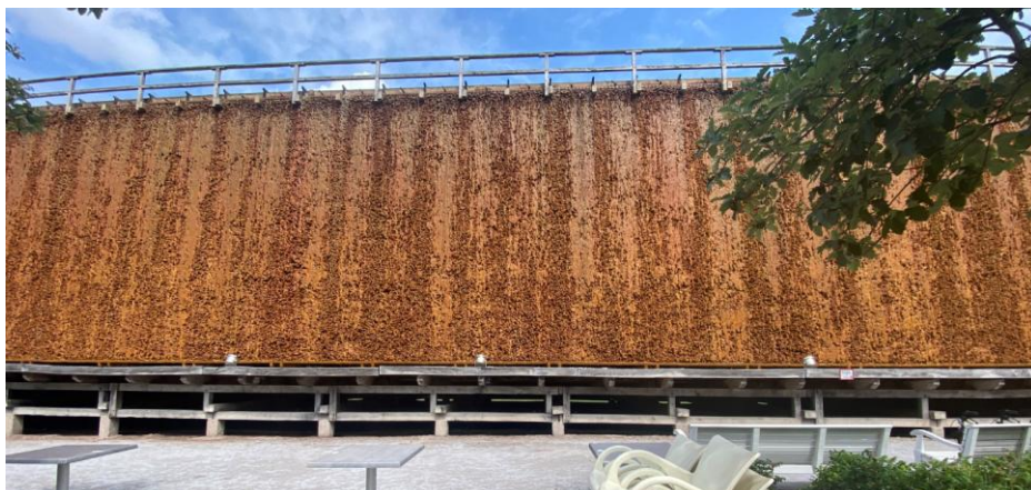
Abbildung 3: Gradierwerk mit sichtbaren Ablagerungen/ Ablagerungen
