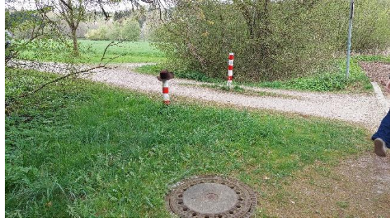
Moosstraße (Schacht EI1113)
