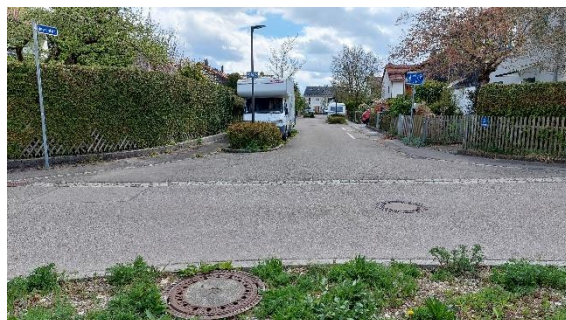
Spielstraße Bussardstraße (Schacht EI1139)
