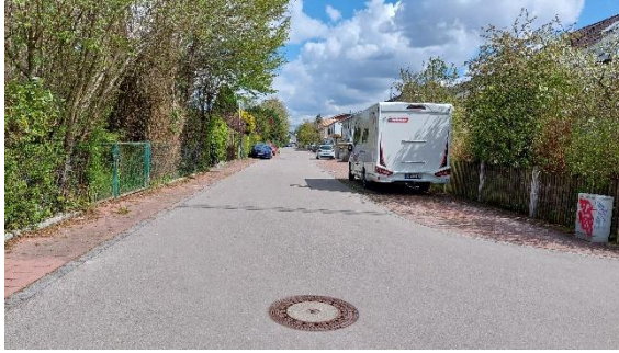
Wohngebietstraße Elsterstraße (Schacht EI2257)
