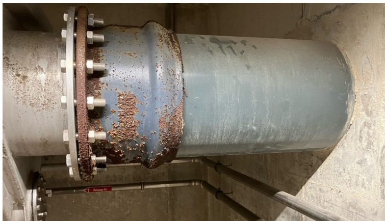
Ablaufrohrleitung DN 400 auf DN 500 erweitern
