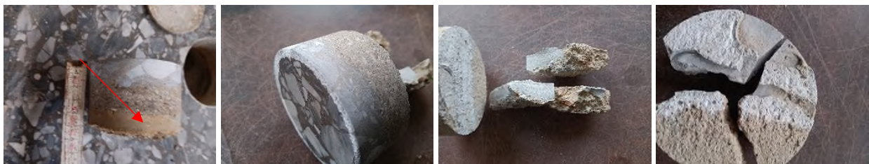
Abbildung 5: KB 3 Betonfliese und Fliesenkleber/Estrich, asbestfrei
