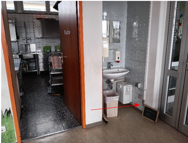
Abbildung 8: Speiseraum; Wand-Verkleidung Waschbecken-Nische: Wandfliesen (P1.1) auf Dickbettmörtel (P1.2); kein Schadstoffverdacht)
