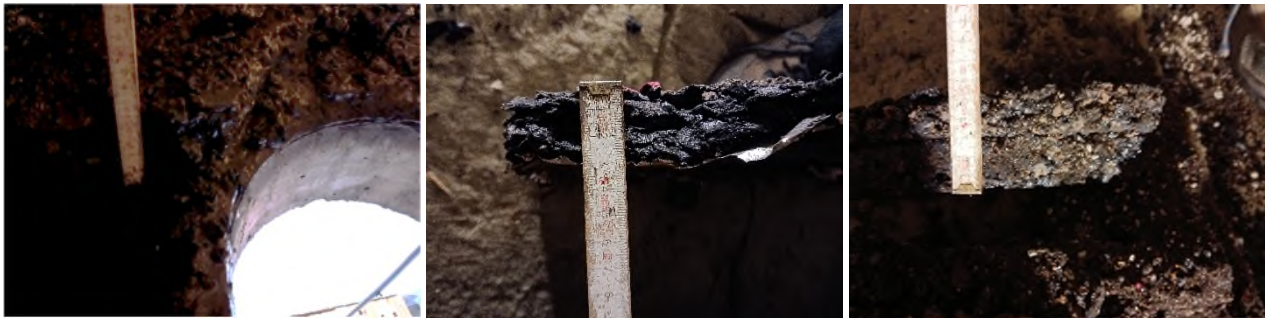
Abbildung 2: Dachaufbau: "alte Mineralwolle", lose (KMF-haltig, P7), Dachbahnen (mehrlagig), Teerkork-Dämmung (2-lagig), Dampfsperre (s. Abbildung 3) auf Beton (unverputzt), (jeweils stark PAK-/teerhaltig)
