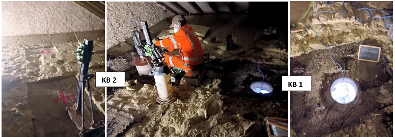
Abbildung 1: Dachboden, Kernbohrungen KB 1 und KB 2 an vorgegebenen Aufschlussstellen
