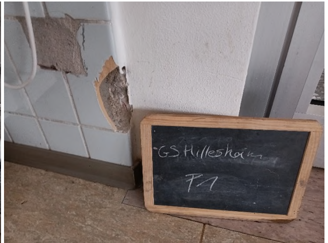
Abbildung 8: Speiseraum; Wand-Verkleidung Waschbecken-Nische: Wandfliesen (P1.1) auf Dickbettmörtel (P1.2); kein Schadstoffverdacht)
