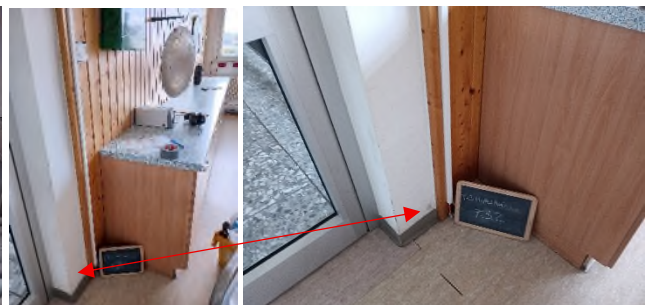
Abbildung 10: Speiseraum, Holz-Wandverkleidung (P3, PCP-belastet); Anstrich Ziegel-Mauerwerk (P3.1), asbestfrei; Wandputz (bei Tür, P3.2) asbestfrei
