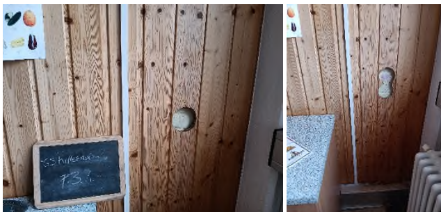
Abbildung 10: Speiseraum, Holz-Wandverkleidung (P3, PCP-belastet); Anstrich Ziegel-Mauerwerk (P3.1), asbestfrei; Wandputz (bei Tür, P3.2) asbestfrei
