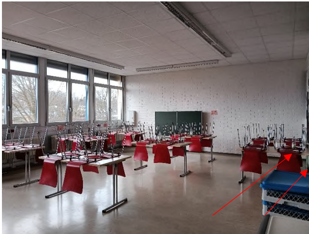
Abbildung 9: Speiseraum, Anstrich Ziegel-Mauerwerk (P2), asbestfrei
